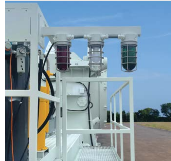
LUCES DE FALLO DEL SISTEMA DE PROGRAMACIÓN DE CONTROLADORES LÓGICOS (PLC, POR SUS SIGLAS EN INGLÉS)
